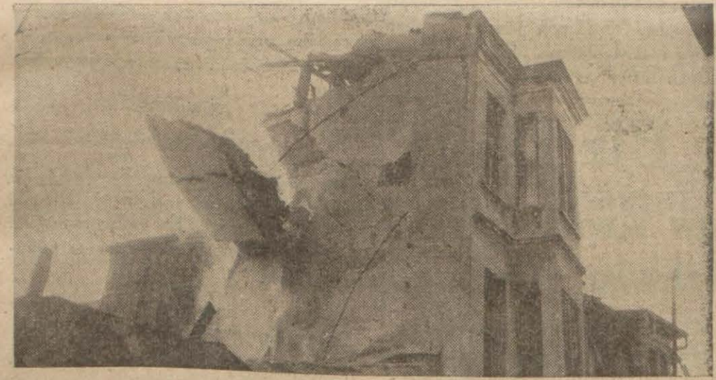
Binanın diğer katları da yıkılıyor.
